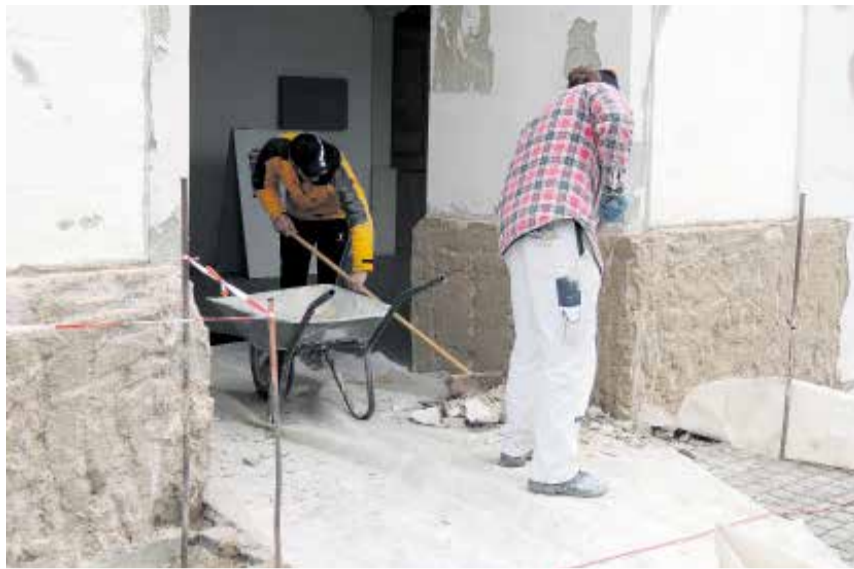
Arbeiter spitzen den versalzene Verputz vom Sockel der Pfarrkirche St. Johann ab. Foto Esther Birrer
